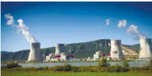
Мал. 46. Атомна електростанція в Мозелі (Франція)
